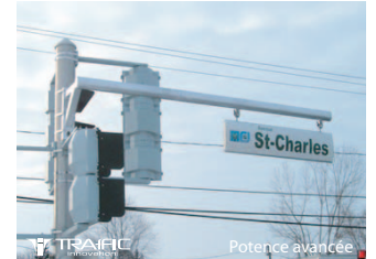
Potence avancée ou centrale, nécessaire lors de cas particuliers
