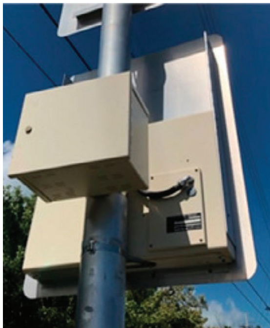
Installation la plus courante de signalisation DEL
